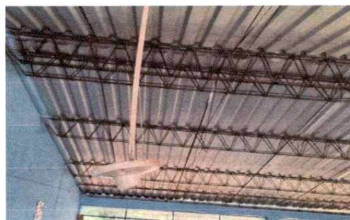
Foto 17.1: Sustrucción de focos 50W Silvana modulo Aulas
