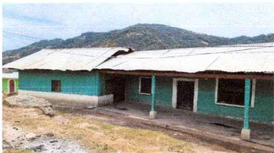
Foto1: Sustitucion de lamina modulo Cocina
