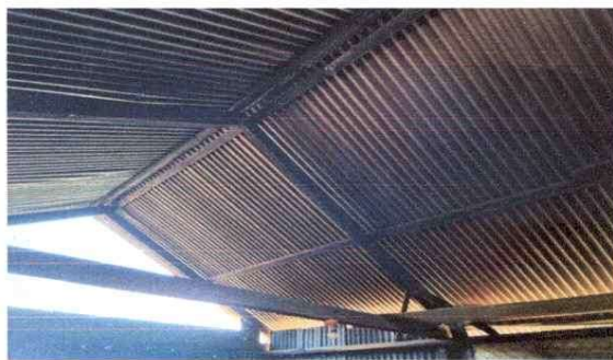
Foto 2.2: Sustitución de estructura de soporte de madera por metal 4x2 módulo cocina
