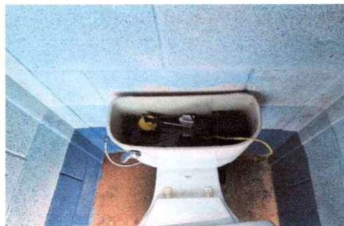
Foto 10.1: Sustrucción de accesorios inodoro (contra llave, tubo de abastro y tanque) módulo baños
