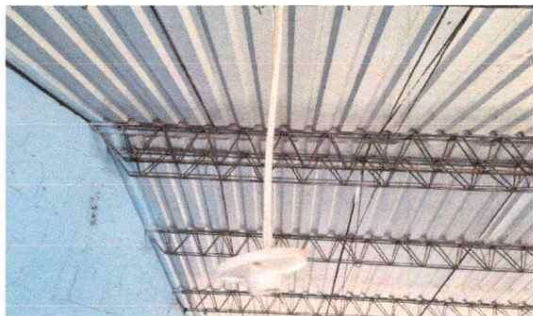
Foto 17.2: Sustitución de plafoneras Bticino modulo Aulas
