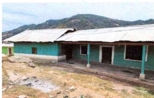
Foto 9.1: Pintura de muros exteriores e interiores módulo cocina
