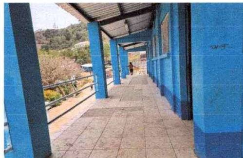
Foto 6.1: Reparación de piso cerámico modulo Aulas
