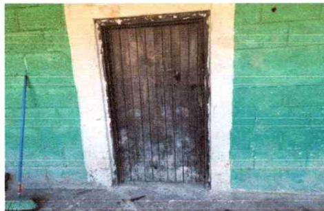
Foto 4.2: Sustitución de puerta de madera por metal módulo cocina
